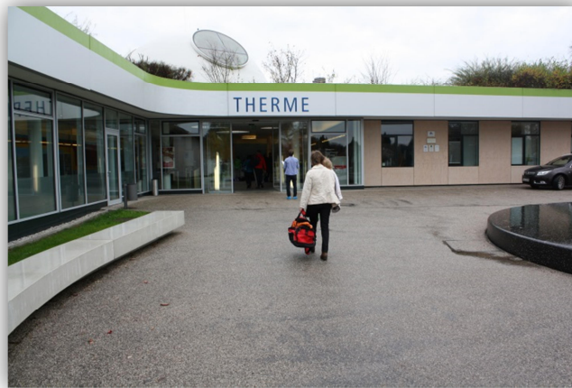
Abbildung 1: Therme Bad Aibling
